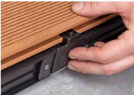
Vor dem Verlegen der Dielen werden die Endklemmen angebracht, in welche die ersten Dielen eingeschoben und verschraubt werden.
