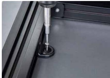
Bei Bedarf kann die Alu-UK auch direkt am Boden befestigt werden. Hierzu dienen die Befestigungswinkel.
