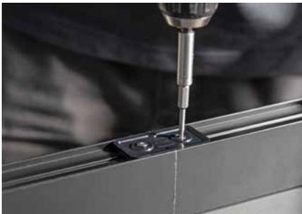
Um die Alu-UK bei Bedarf zu verlängern, werden diese beidseitig mit den Alu-Verbindern und den mitgelieferten Schrauben verbunden.
