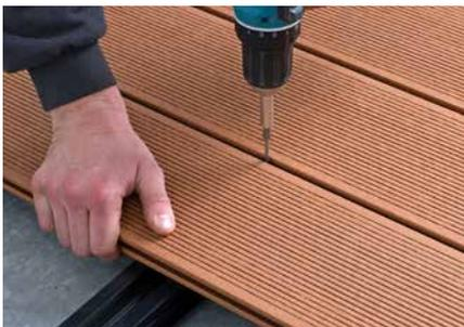
Nach jeder Dielenreihe werden die Universal-Clips verschraubt. So wird ein sicherer Halt jeder einzelnen Diele gewährleistet.
